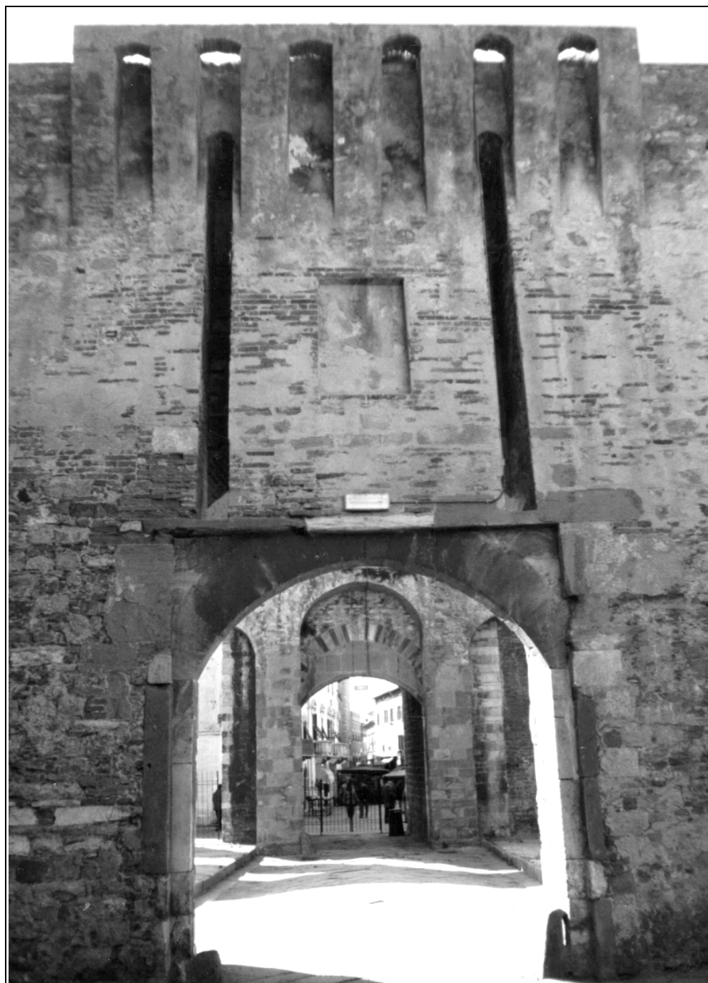
Antiporta del Torrione, 1420/1430. Piombatoi e aperture verticali per l'alloggiamento dei bolzoni del ponte levatoio.
