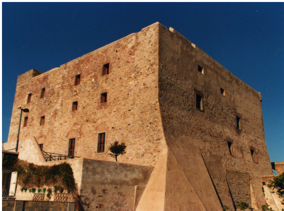
Castello, fronti Sud e Est. Visibile l'attacco dell'ampliamento di Giovanni Camerini nel lato Sud, XV - XVI secolo.
