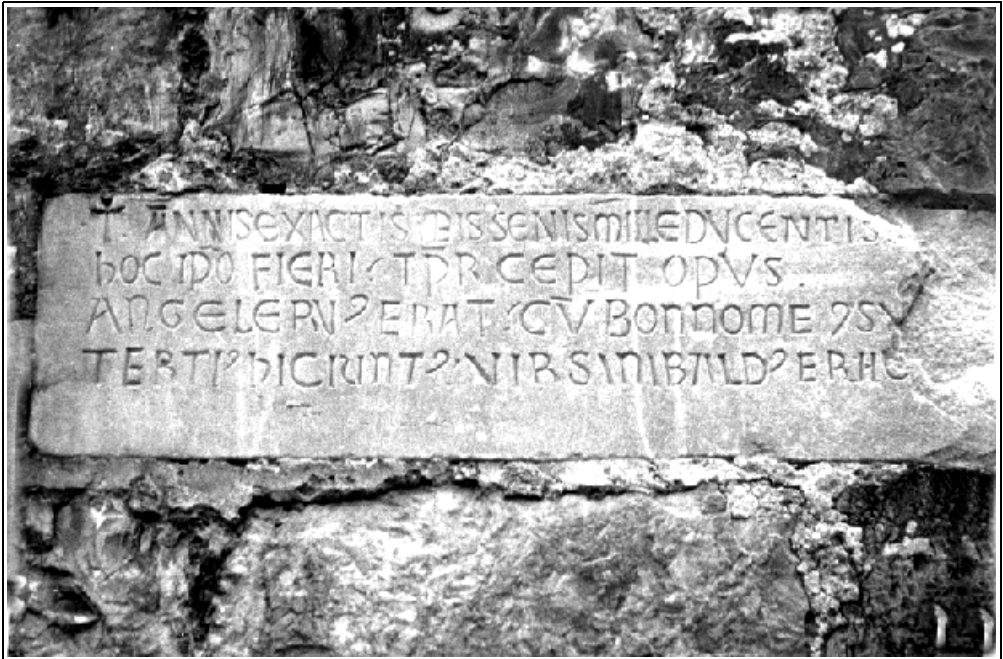
Epigrafe per la costruzione del Torrione, 1212.
