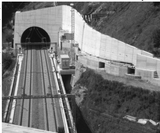
Imbocco alta velocità sul torrente Diaterna.
