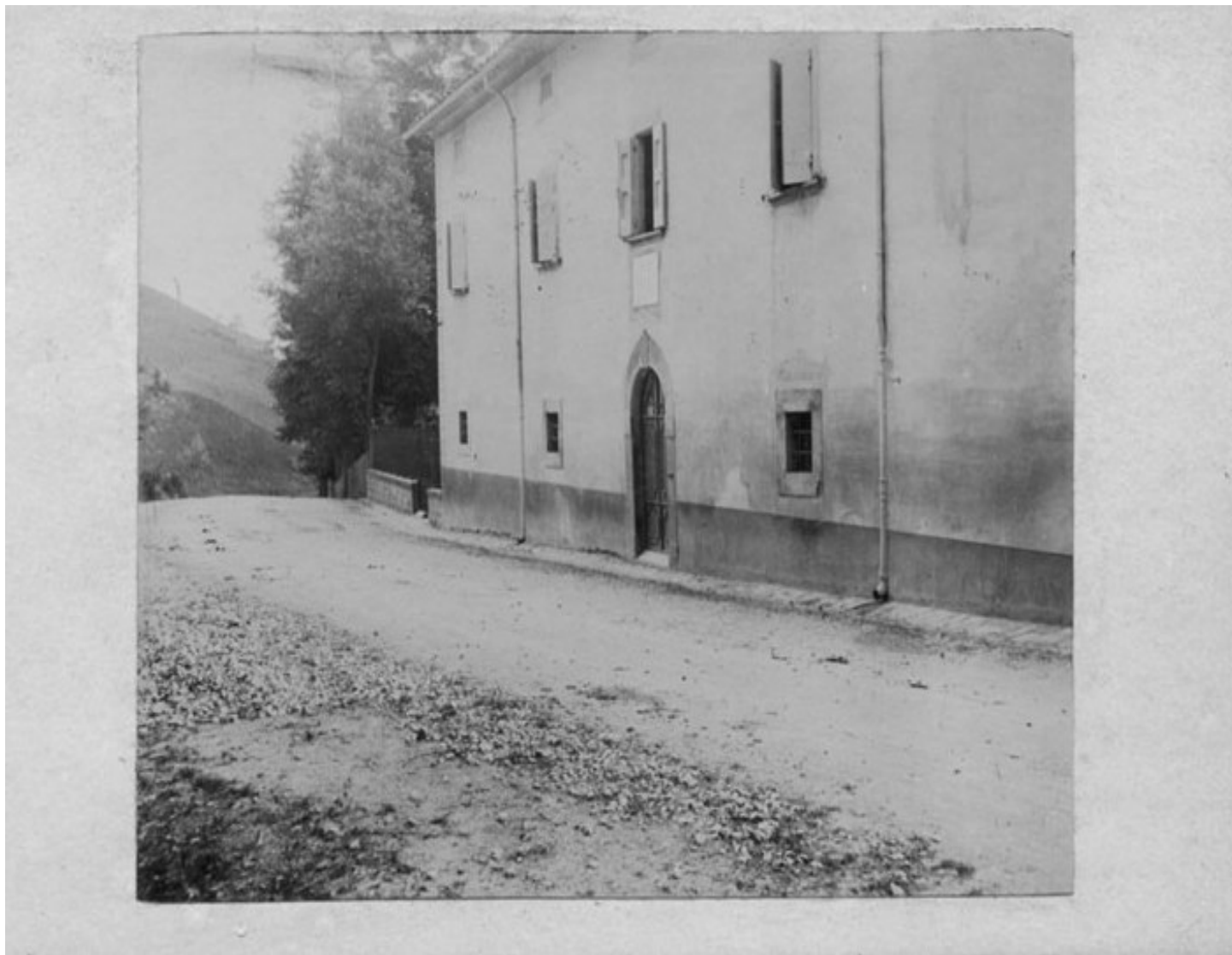
Casa dell'antica Posta e Locanda poco oltre il Ponte delle Filigare verso Firenze.
