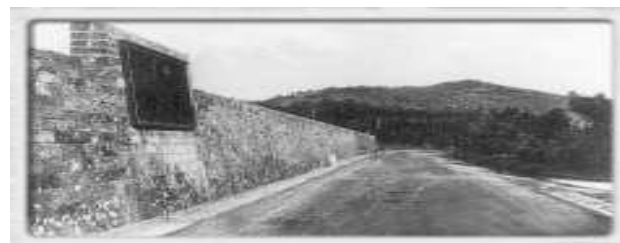
Il "Muraglione" costruito dal Granduca sulla strada della Futa.
