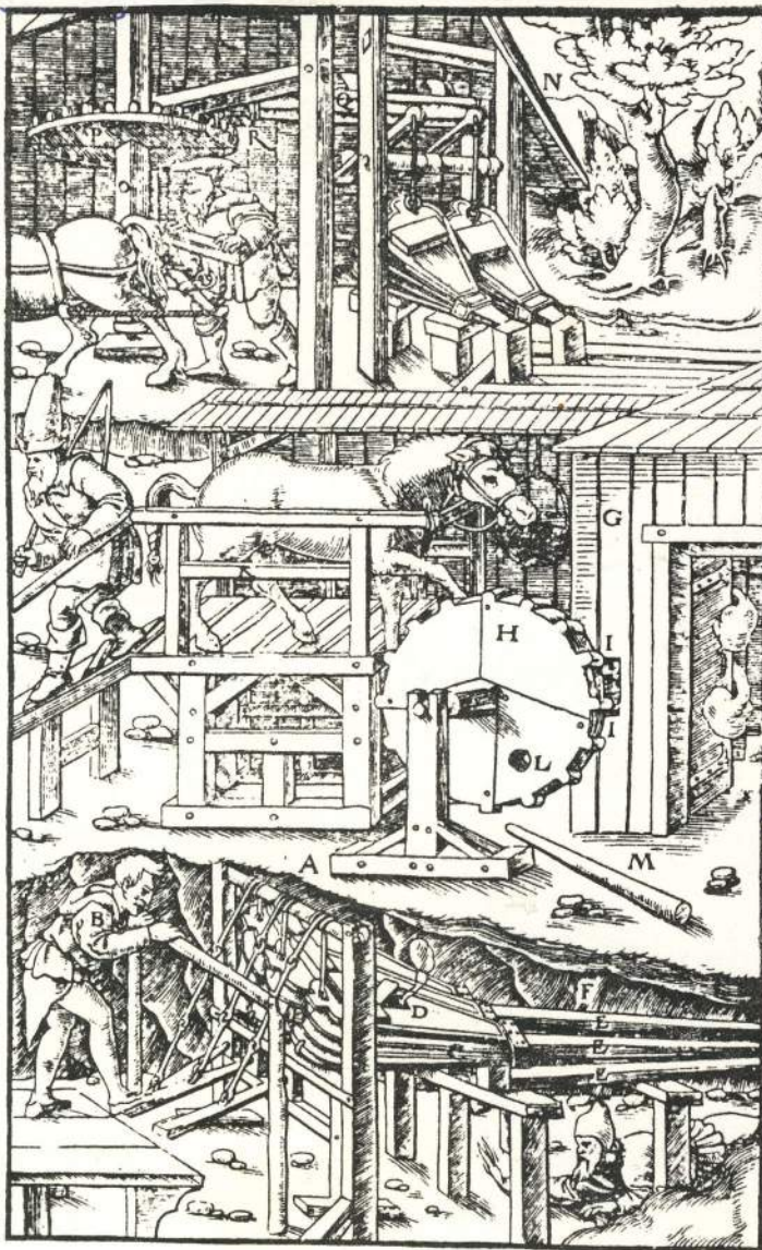
■ IMPIANTI PER L'AREAZIONE DEI POZZI E DELLE GALLERIE DELLE MINIERE
