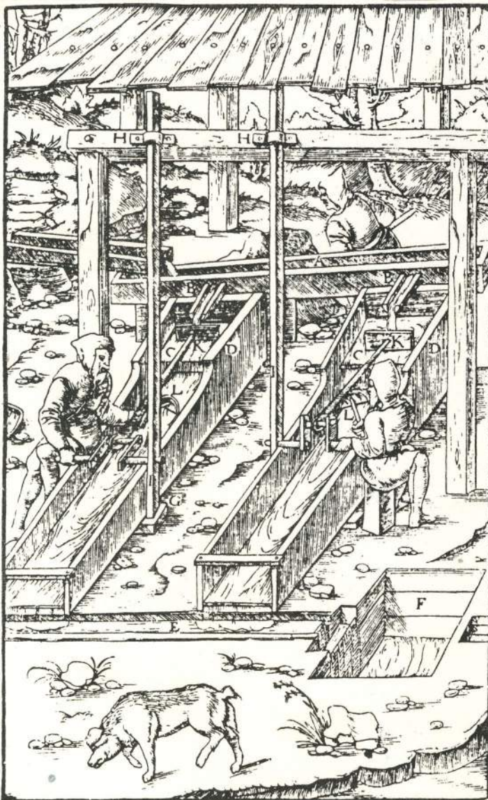
■ IMPIANTI DI LAVAGGIO DEL MINERALE
